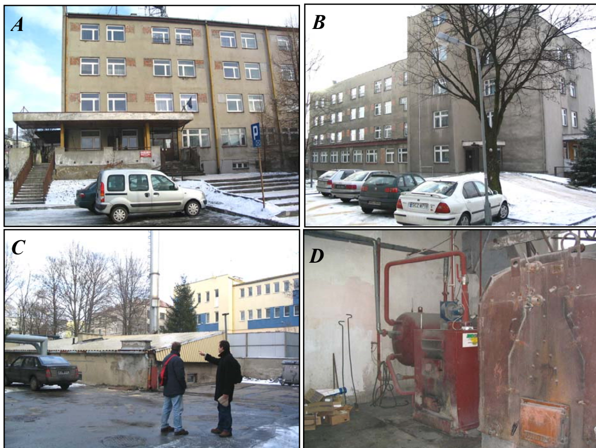
Rys. 1. Szpital Rejonowy w Kłobucku: A – elewacja frontowa, B – elewacja tylna, C – kotłownia przyszpitalna, D – wnętrze kotłowni przyszpitalnej (na pierwszym planie widoczny kocioł parowy wykorzystywany do celów CO, następnie kocioł CWU i zasobnik 2 m 3 )
